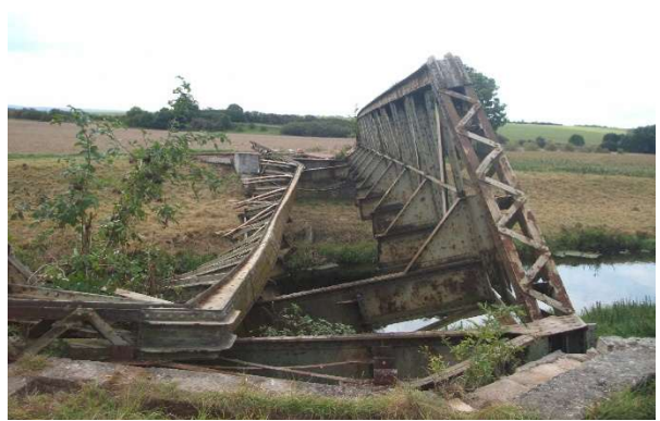
Abriss 29.08.2007 (Bild: Ingolf Jaritz)
