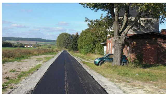
Bitumendecke am 20.09.2011 (Bilder: Ingolf Jaritz)
